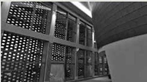
▲現在の工事の様子(3月4日撮影)
