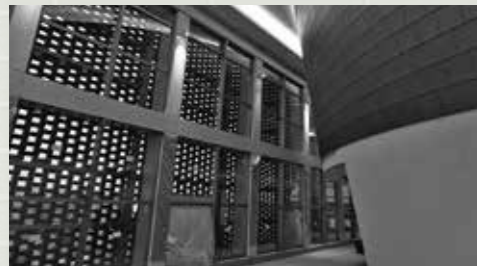
▲現在の工事の様子 (3月4日撮影)
