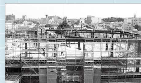
▲現在の工事の様子(7月17日撮影)
