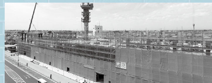
▲6月14日の工事の様子。
