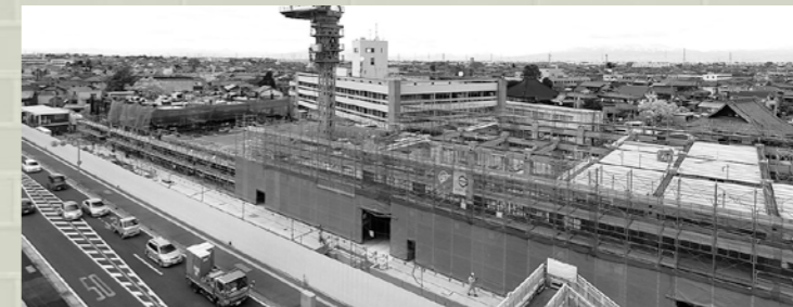
▲新庁舎建設の様子(4月11日撮影)
