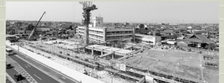
▲3月15日の工事の様子。
