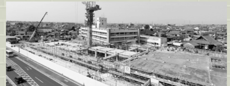
▲3月15日の工事の様子。
