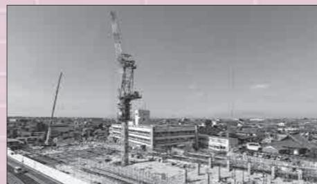
▲現在の工事の様子(2月15日撮影)
