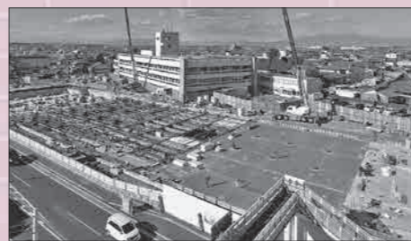
▲現在の工事の様子（1月17日撮影）
