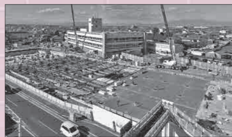
▲現在の工事の様子（1月17日撮影）
