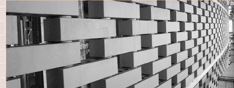
▲現在の工事の様子(11月18日撮影) 外装工事でレンガを積んでいます。
