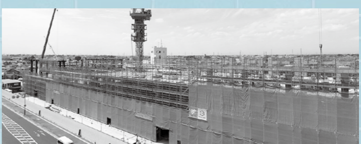
▲6月14日の工事の様子。
