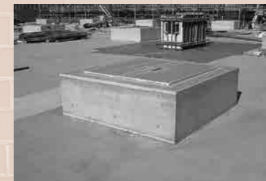
▲この基礎の上に免震装置（積層ゴム）を設置します。
