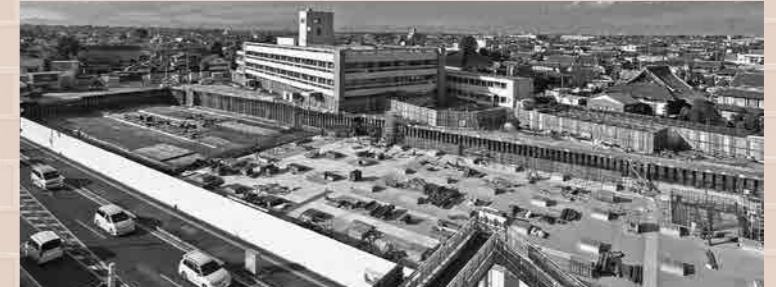
▲現在の工事の様子（11月17日撮影）
