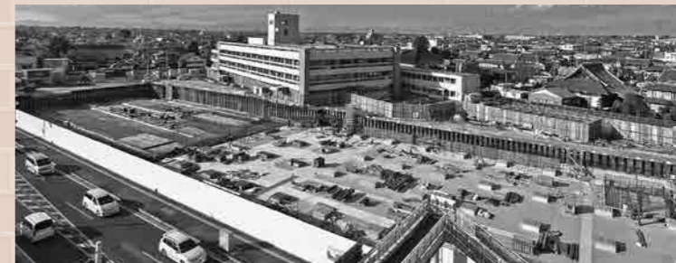
▲現在の工事の様子（11月17日撮影）
