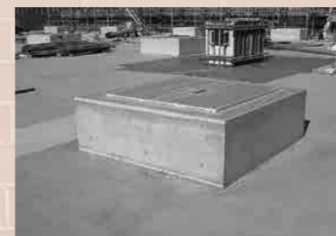
▲この基礎の上に免震装置（積層ゴム）を設置します。
