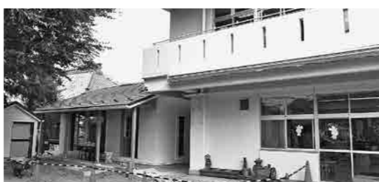
▲補助金を活用した施設整備の一例(施工中)。左側が増築した低年齢児用の部屋です。増築以外にも改築など、施設に応じた整備が実施されます。
