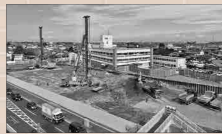
▲現在の工事の様子(9月18日撮影)
