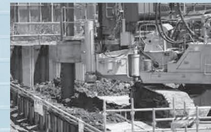
◀地盤改良工事で、回転駆動機(オーガ)を使用し、固化材(セメントミルク)を注入しながら土と混ぜて地盤を柱状に強化する様子。
