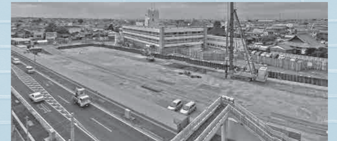
▲現在の工事の様子。右上の重機で地盤改良を進めます。
