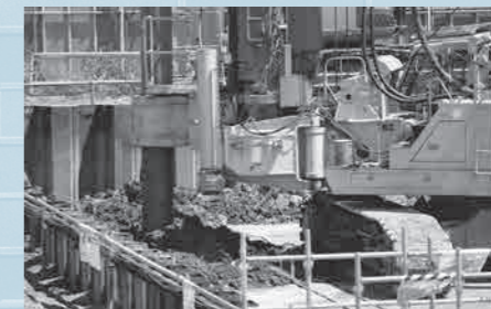
▲現在の工事の様子。右上の重機で地盤改良を進めます。
