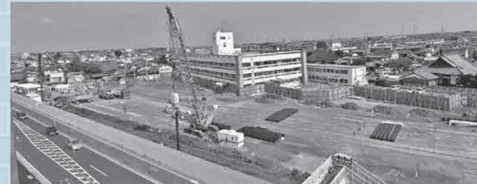
▲7月21日の工事の様子。中央の重機で鉄板を打ち込んでいます。
