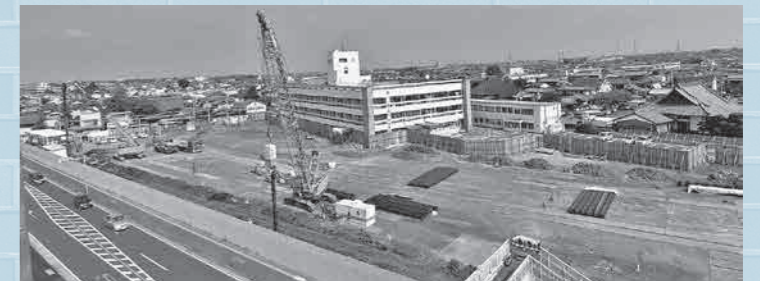
▲7月21日の工事の様子。中央の重機で鉄板を打ち込んでいます。
