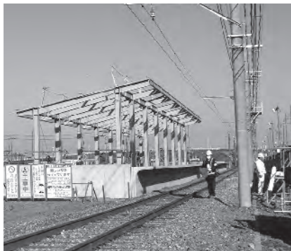
▲『ふかや花園駅』建設現場。平成30年10月20日に開業予定です。
