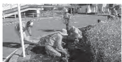
▲秩父鉄道武川駅南口ロータリー
