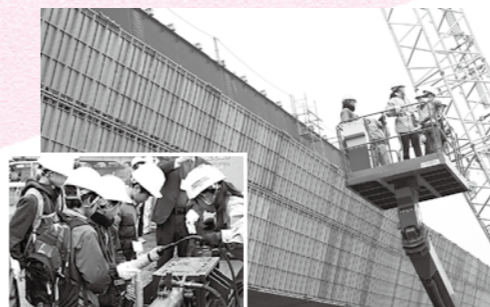
参加者は建設中の橋げたに接近したほか、橋げたを送り出す装置の操作も体験しました
