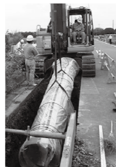
▲新たな水道管を地中に埋める作業
