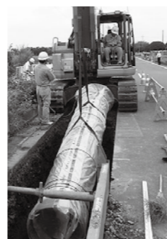
▲新たな水道管を地中に埋める作業
