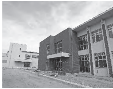
▲お客様センターなどが入る水道庁舎(手前右)と、浄水管理棟(左奥)
