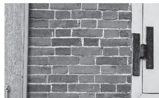
▲『和洋混交』の技術で作られた漆喰は、今も富岡製糸場の建物の煉瓦をしっかりとつなぎ合わせ、支えています。（画像提供：富岡市・富岡製糸場）
