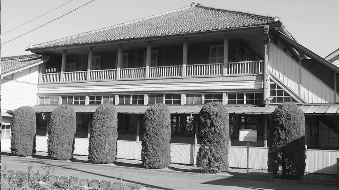
女工館（2号館）：富岡製糸場で、フランス式の器械繰糸技術を工女（製糸場の若い女性労働者）に教えるフランス人女性教師（教婦）の宿舎として、明治6年に建設されました
