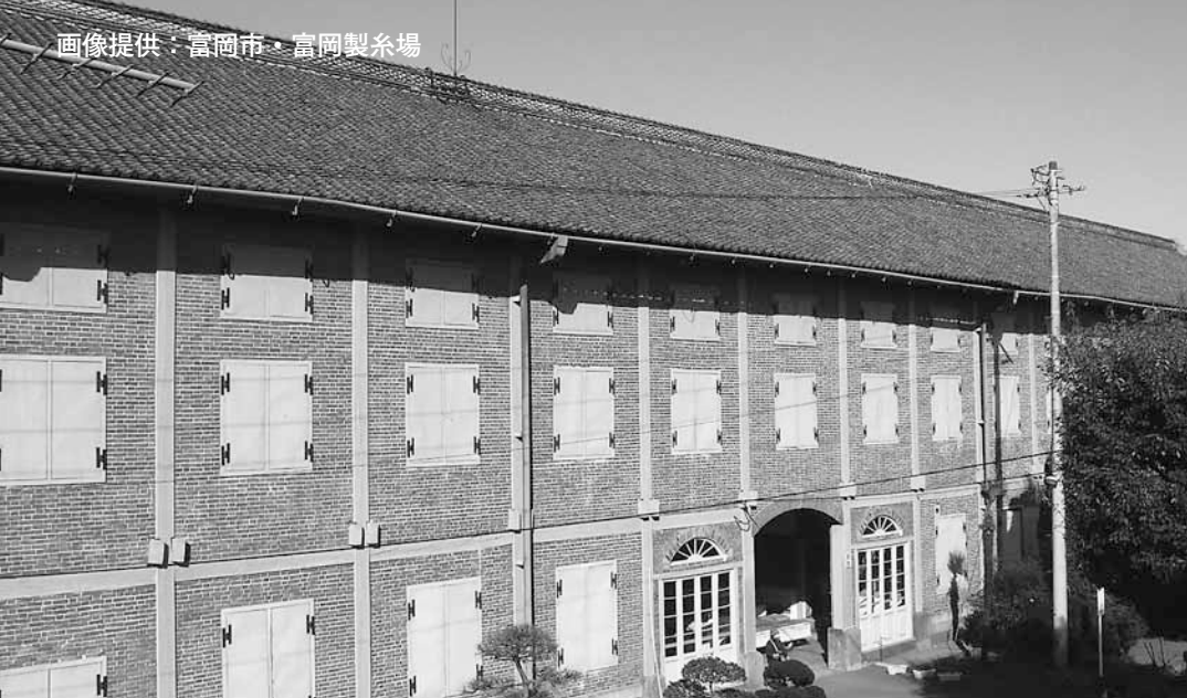
東繭倉庫：乾燥させた繭の貯蔵を主な目的とした倉庫で、西側にも同規模の建物（西繭倉庫）が配置されています。東繭倉庫は、富岡製糸場に入ると最初に目にする建物です
