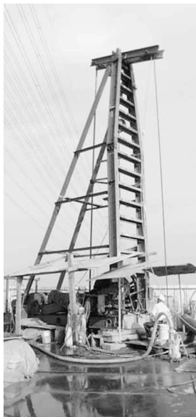
▲⑥岡部浄水場のさく井工事:井戸の掘削工事では深さが約200mに達します
