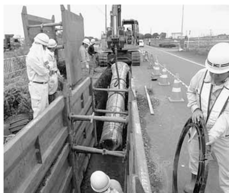
▲⑦基幹配水管整備(コスモス街道・岡部地区)
