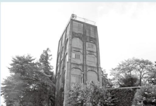
周辺の軍施設に給水するために建設された塔で、一時期は松根油を採取する装置も設けられていました。内部は5層構造で、昭和30年以降は住宅として改造されています。鉄筋コンクリートのラーメン構造が外観にそのまま現れており、その特異な外観で知られています。
