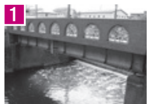
1 唐沢川鉄橋 欄干(縁側部分)は増築されたものですが、基礎の部分(橋台と桁)は鉄道敷設当時のまま残っています。
