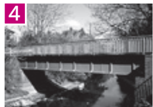
4 備前渠鉄橋 (国重要文化財) 旧日本煉瓦製造(株)近くの遊歩道終点にあるポータル型プレートガーダー橋です。専用線に架けられた鉄橋は、当時4本ありましたが、この橋はその中で最長の15.7mあります。橋の手前には、長さ約2mの煉瓦アーチ橋(写真下)が架かっています。
