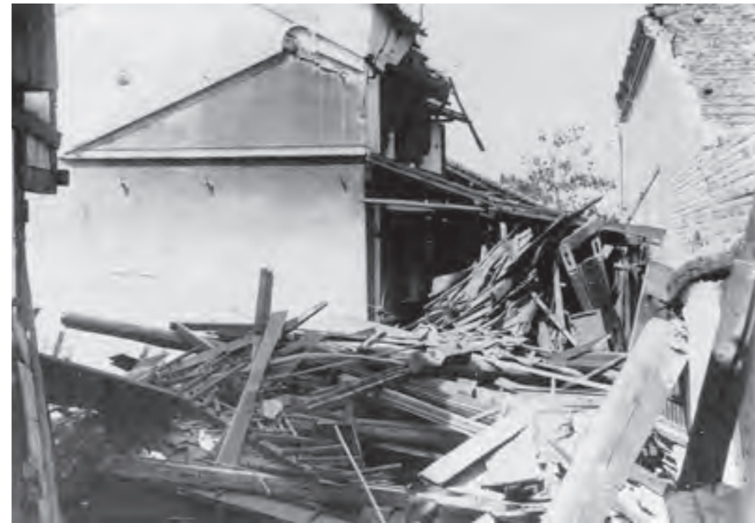
▲昭和6年西埼玉地震で倒壊した家屋と煉瓦(出典:深谷市史)
