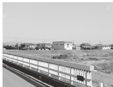
小山川橋から撮影（深谷市側）
