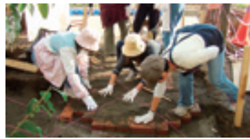
並べたレンガに目地を入れていきます
