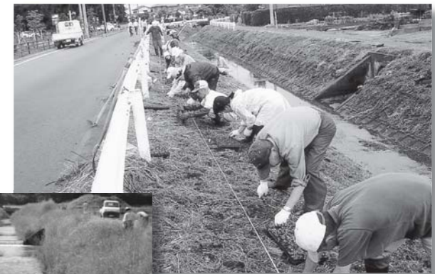
ヒメイワダレ草の植え込み作業中
