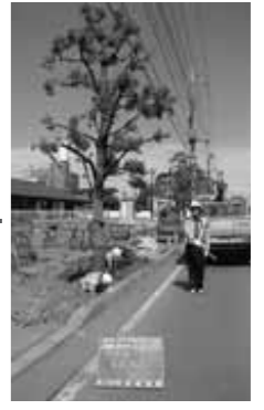
移植作業 (駅通り工場団地線)
