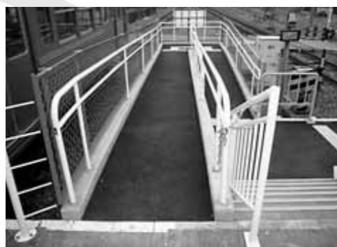
完成したスロープ：秩父鉄道 明戸駅
