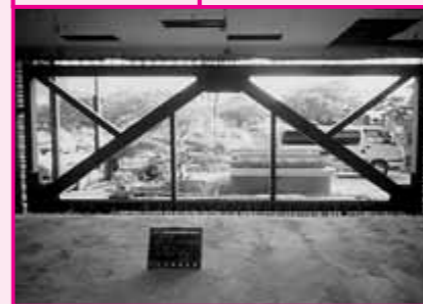
補強工事中（鉄骨ブレス設置）
