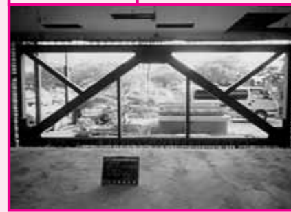
補強工事中(鉄骨ブレス設置)
