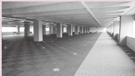
▲現在の工事の様子（2月18日撮影）
