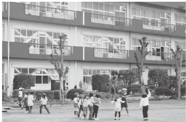
市内小学校の耐震補強進む（岡部小学校）
