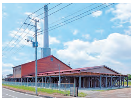
保存修理終了後のホフマン輪窯外観
