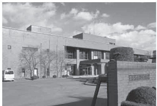
浄化センター
