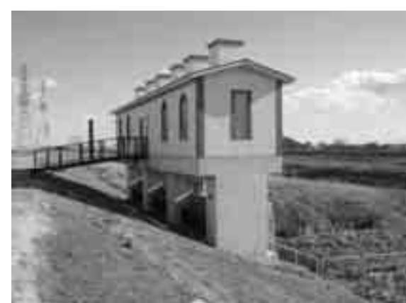
清水川排水機場
