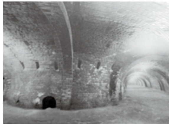
重要文化財 旧煉瓦製造施設 ホフマン輪窯内部
