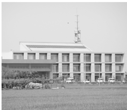
消防本部 太陽光パネル付屋根
