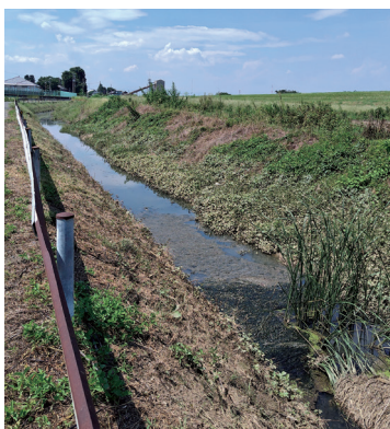
豊里地区の水路状況
