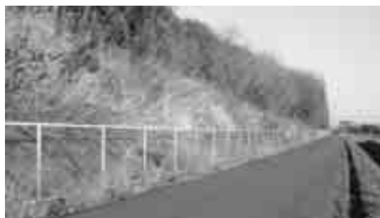
関越道・側道斜面
