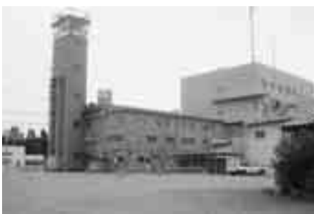
旧深谷消防庁舎
