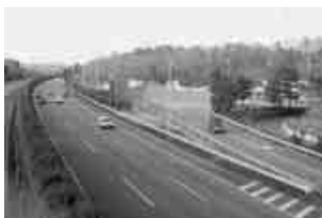
関越道・寄居パーキングエリア
