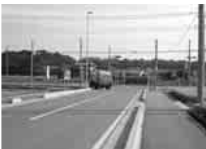
重忠橋南側と主要地方道熊谷・寄居線との交差点
