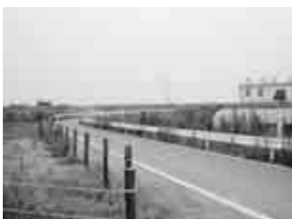
市道幹18号付け替え道路
